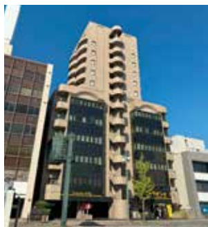
新たに入居したビル
