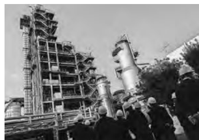
レゾナックガス化プラント
